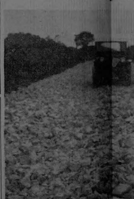
Esta es una magnífica perspectiva del camino en construcción que conectará al puerto de San Marcos de Tarrazú.
