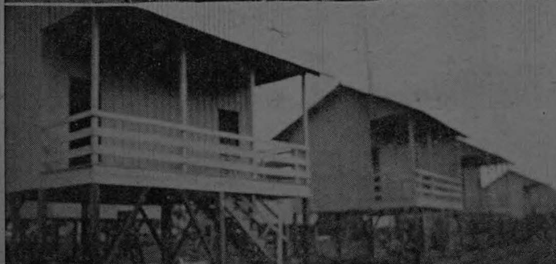
Este es un lote de nuevas viviendas para trabajadores del abacá en Bataan. Como éstas y también, en otros estilos, la CBCR está construyendo multitud de viviendas tanto en la zona atlántica como en el Pacífico. Se aprecia en las gráficas superiores el proceso de construcción. Abajo, algunas de las casas terminadas.
