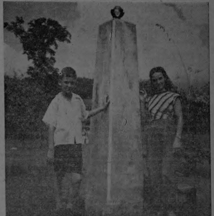
Este monolito que se alza en un jardín de Piedras Blancas, no hace otra función que la de sostener uno de los aparatos con que determina la intensidad de la radiación solar y otros aspectos de control atmosférico. El hijo de nuestro Director y una joven profesora, han estado a observar el funcionamiento de ese aparato, uno de los muchos instalados por la Compañía Bananera para llevar un mejor control del tiempo en beneficio de la agricultura en las zonas costeñas.
