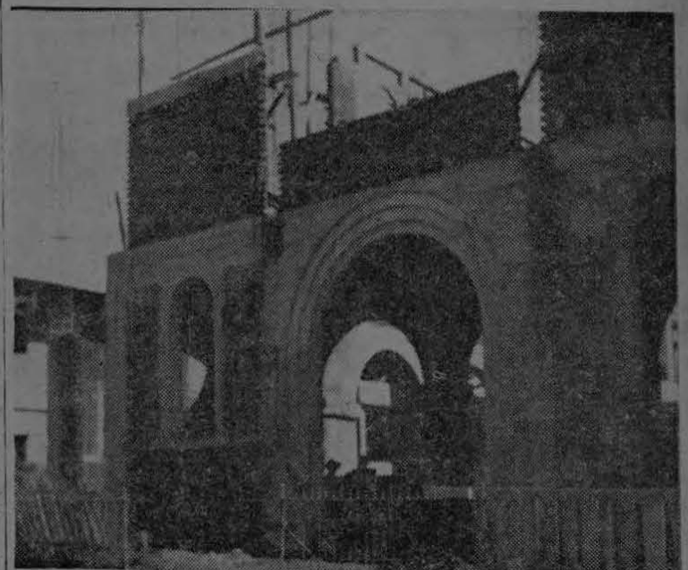
Esta es una gráfica del estado actual de los trabajos de construcción de la Catedral del Vicariato Apostólico de Limón. Los trabajos avanzan. La hermosa construcción es una esperanza que los limonenses están convirtiendo en realidad.
